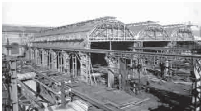
Fase di costruzione delle volte delle officine navali (foto: Consorzio Culturale Monfalconese)
